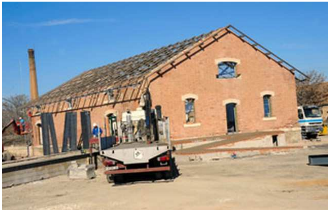
Figura 24. Estación de Autobuses en construcción (Fotografía publicada en La Tribuna, Luís Bonete).
