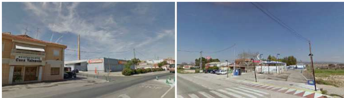
Figura 15. Ejemplos de edificaciones existentes (POM)
